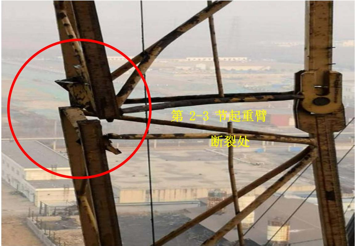
图 2-9 第 2-3 节起重臂断裂处
