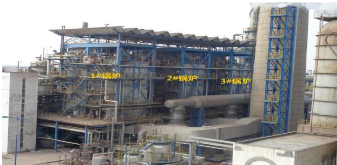
图 1：大港石化公司公用系统车间锅炉单元现场图
