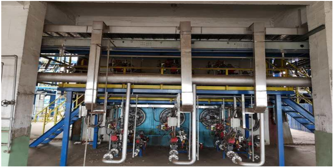
图 3: 1#锅炉燃烧器分布图
