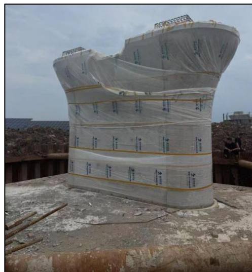
图 2 墩柱拆除后现场图
