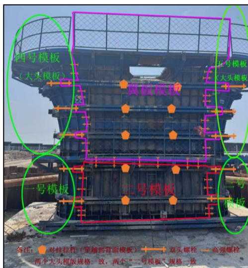
图 5 模板及紧固件一侧示意图
