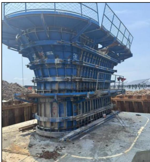
图 1 墩柱拆除前情况图
